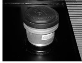
Крышка 4" запасного вентиляционного отверстия бака
