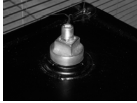
Отсечной выключатель низкого уровня топлива
